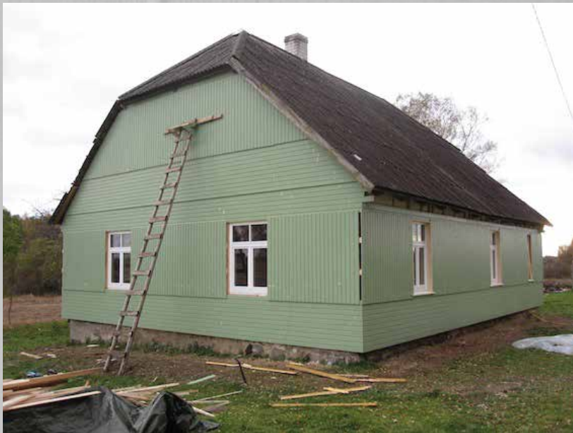
Uus vooderdusega, soojustatud välisfassaad
