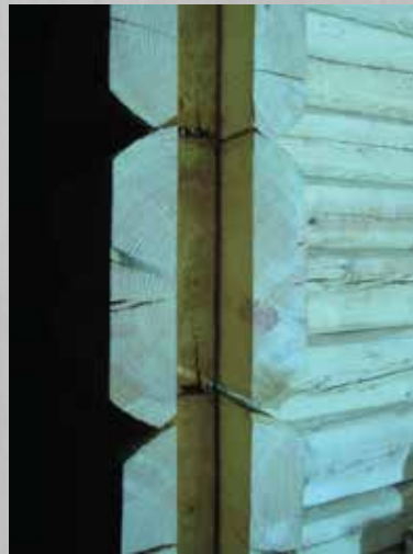
Korrektne tenderpost
