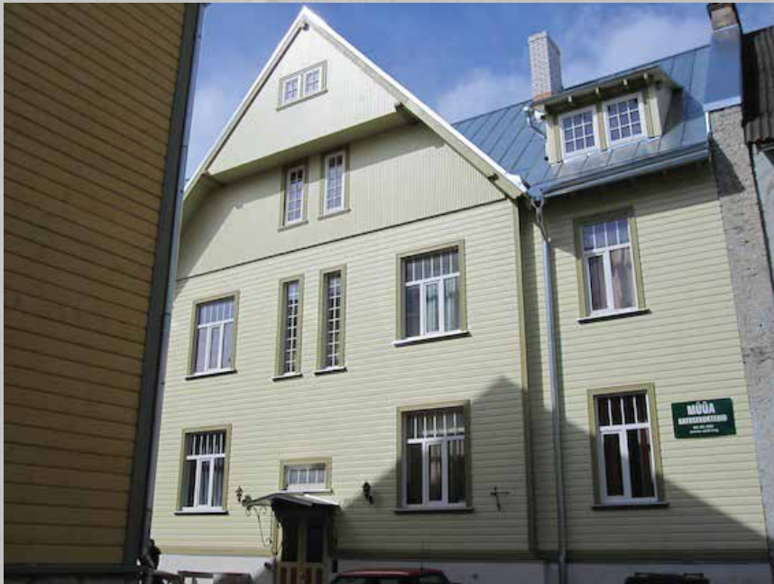
Uue vooderdusega, soojustatud välisfassaad
