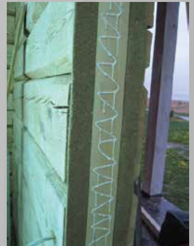
Tenderposti keel, millele kinnitatakse 50 x 200 pruss
