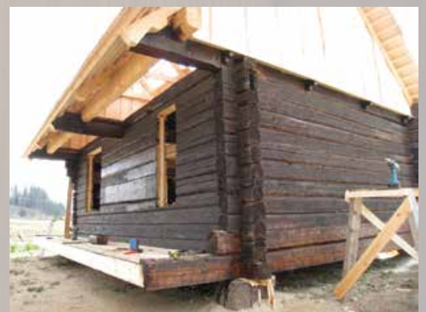
Praktika käigus püstitatud palksaun Võrumaal. Püstitatud saunale ehitati katusekonstruktsioon ja paigaldati laastukatus.
