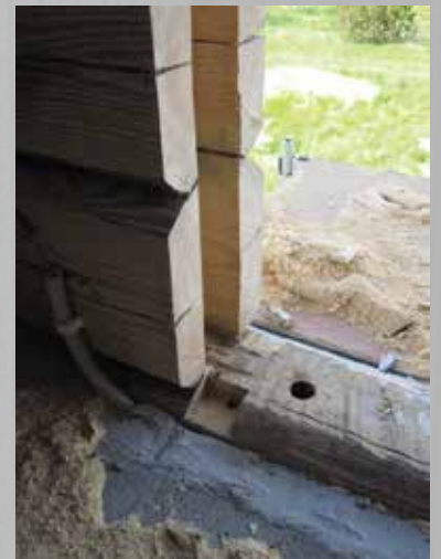
Korrektne tendri tapp
