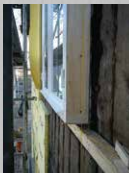
Vana akna uus välimine kiht
