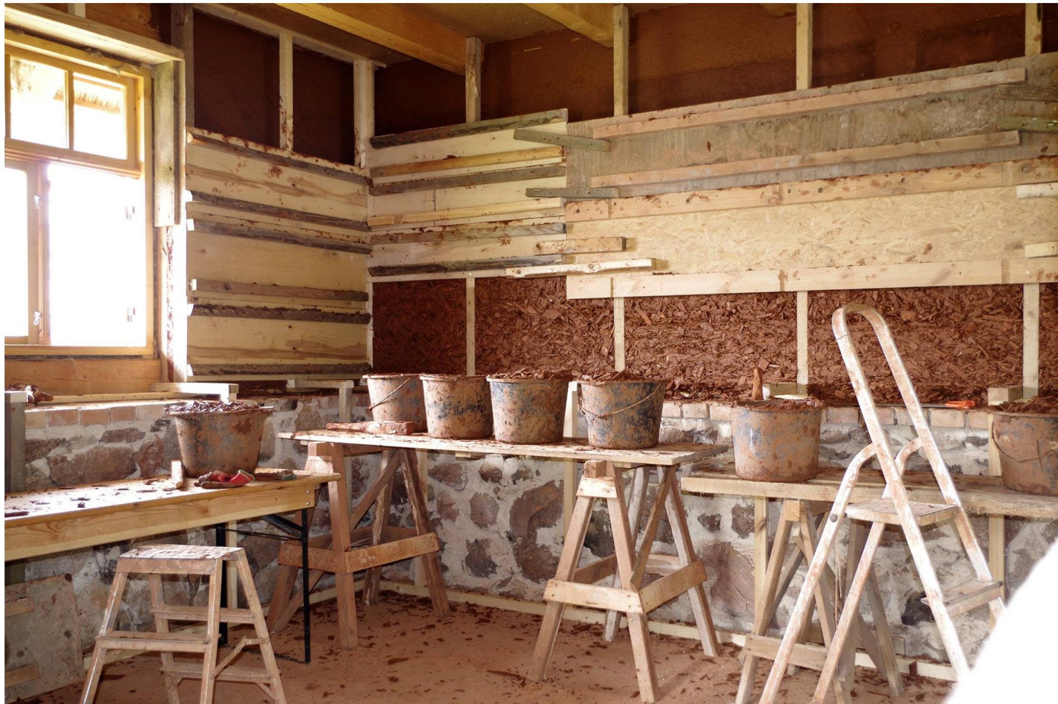
Saviehituspraktika raames püstitatud hakkepuidust kergsavisein
