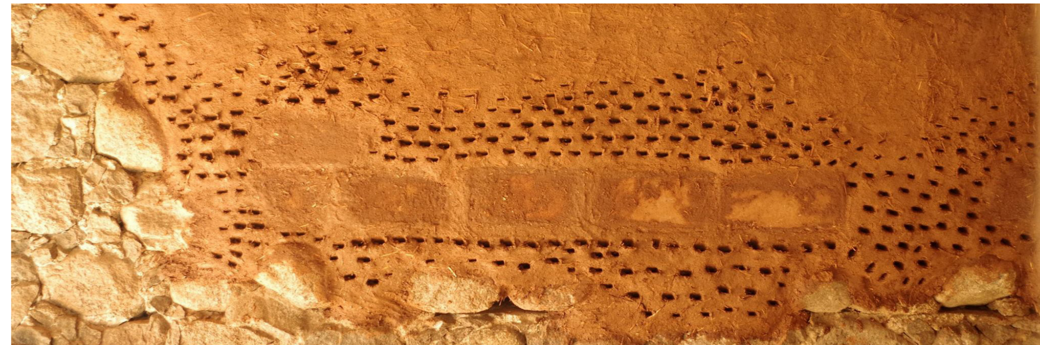
Ülal segu tõmbetugevuse määramine ning all taastatud savisein
