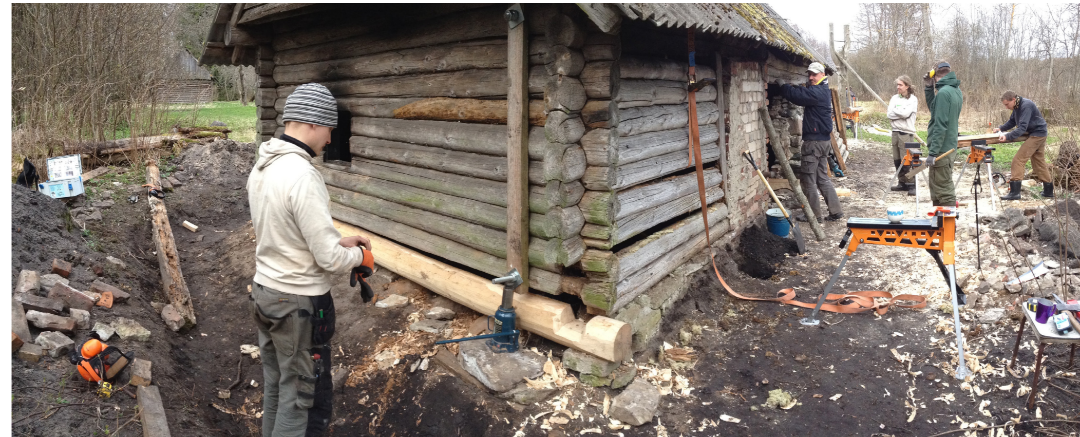
Ülal renoveerimispraktikal taastatav saun ja all taastatud nurgaseotis
