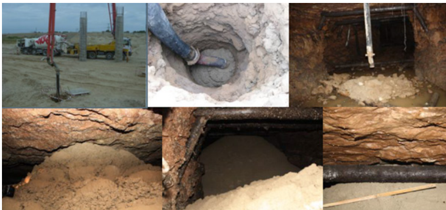
Joonis 3. Kukruse kaevanduse streki täitmine maantee ehitusel (Valgma, Kolats, Karu 2010)
