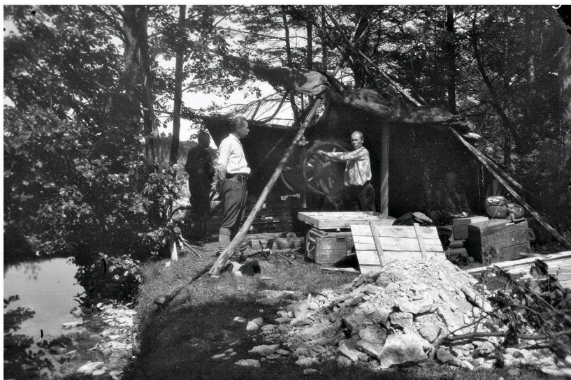
Foto 2. Geoloogiline puurimine Kuusnõmme lähedal Vesiku ojal. Foto tehtud 1927–1928, autor A. Luha. TÜ geoloogiamuuseumi fotokogu.
