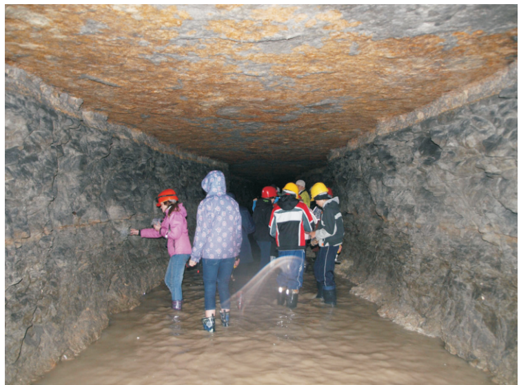
Pääsküla blindaaži sisevaade Vahetult lae all on bentoniidi kiht
