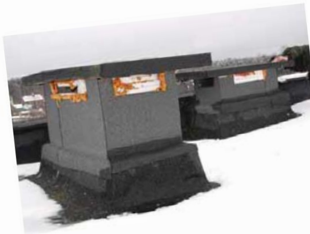
Joonis 13.2 Ventilatsioonilõõrid on katusel suletud.
