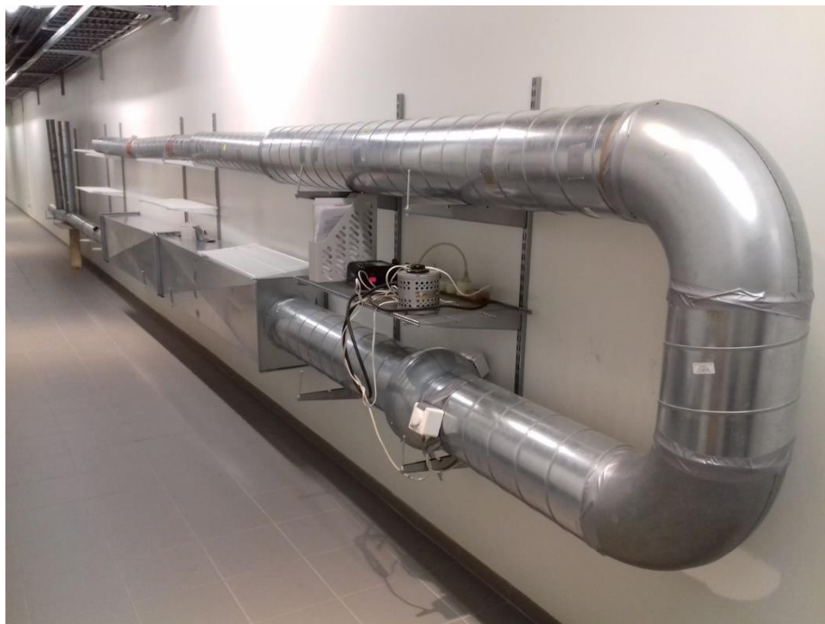
Joonis 2 Esimese kolme ülesande täitmiseks konstrueeritud ventilatsioonistend
