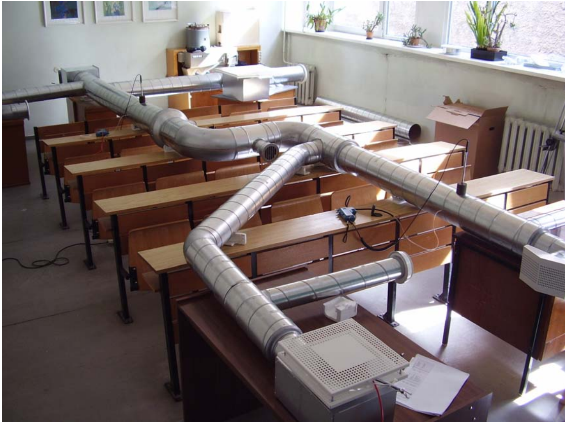
Foto 6. Ventilatsiooni katseseade ruumis 014.
