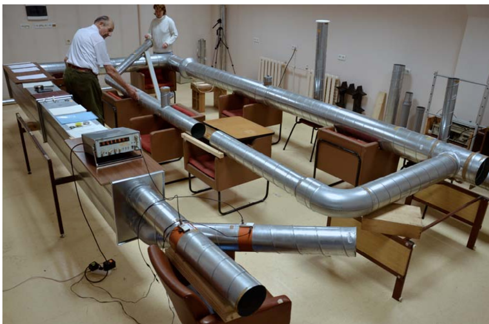
Foto 3. Katsesend ventilatsioonisüsteemi parameetrite võrdlusmõõtmisteks
